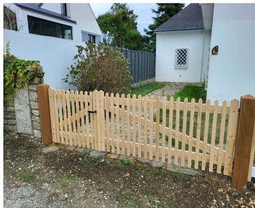
Composés de montants, traverses et écharpes en châtaignier .
